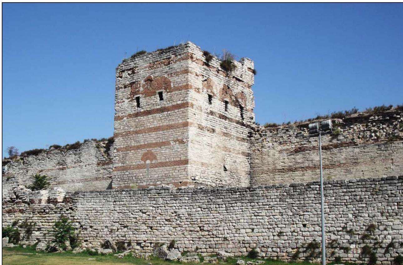
**Рис. 8.** Ранневизантийские стены и башни Константинополя, возведенные в технике opus mixtum в первой половине V в. (фото автора, 2017 г.).
